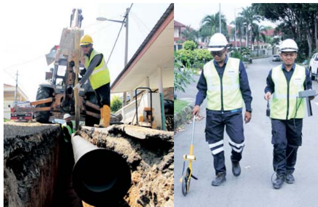
Sejumlah RM161.9 juta telah dibelanjakan pada tahun 2019 untuk kerja-kerja penggantian 168.34 km paip lama dan yang kerap pecah. (Gambar kanan) - Kerja-kerja mengesan kebocoran.
